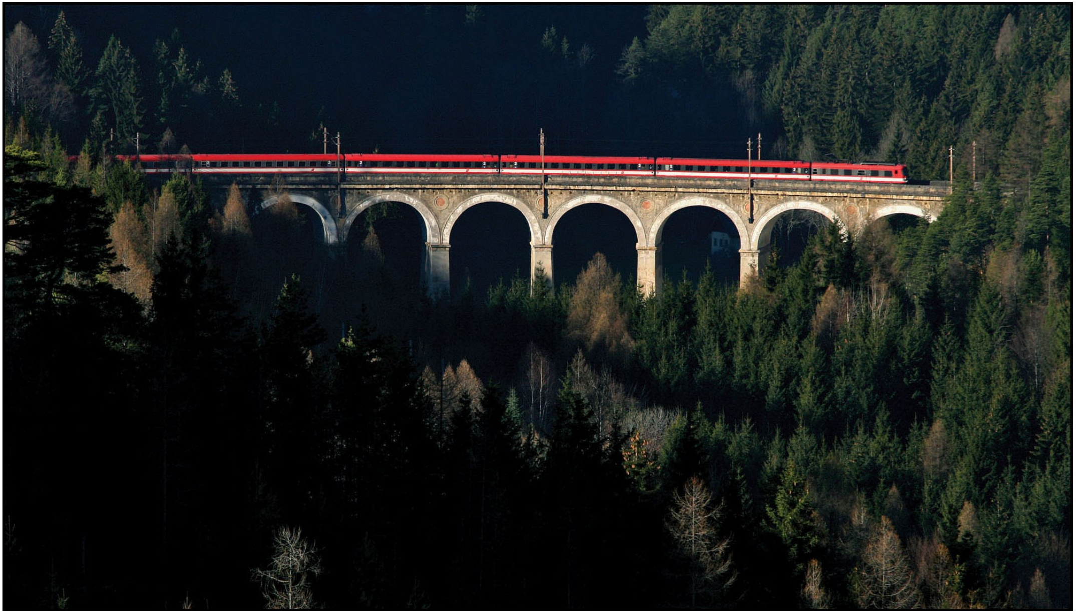
IC 552, Breitenstein, Kalte Rinne Viadukt, 1. 12. 2006
