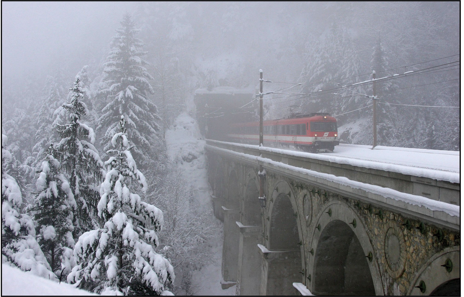
4010.007, IC 552, Breitenstein, Krauselklaus Viadukt, 6. 1. 2006
