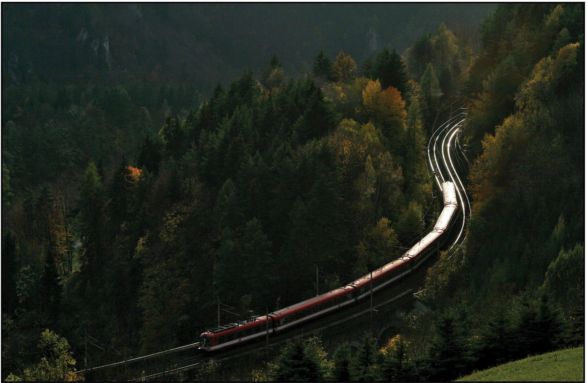
IC 559, Klamm-Schottwien, Wagnergraben Viadukt, 31. 10. 2006
